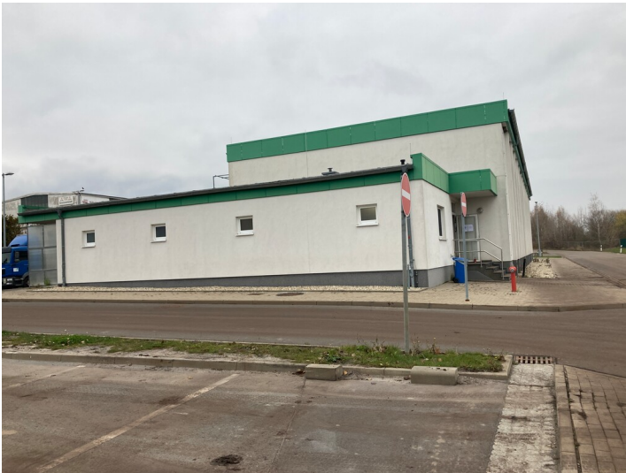
Zweckbau mit Waschkäue, Umkleide und Kantine der Tagesanlagen Fotograf/Urheber: Ullrich Ochs
