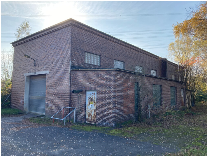
Teil der Objektgruppe ehemaliges Braunkohlenveredelungswerk Espenhain (30100035), Pumpenhaus und Wasseraufbereitung des ehemaligen Braunkohlen- und Großkraftwerk Espenhain Fotograf/Urheber: Cynthia Thomas
