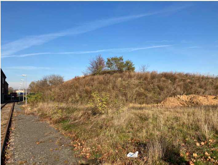
Teil der Objektgruppe ehemaliges Braunkohlenveredlungswerk Espenhain (30100035), Hochbunker 2 des ehemaligen Braunkohlen- und Großkraftwerk Espenhain Fotograf/Urheber: Cynthia Thomas
