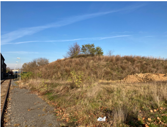
Teil der Objektgruppe ehemaliges Braunkohlenveredlungswerk Espenhain (30100035), Hochbunker 2 des ehemaligen Braunkohlen- und Großkraftwerk Espenhain Fotograf/Urheber: Cynthia Thomas
