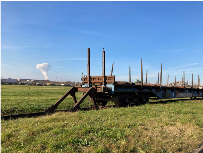
Teil der Objektgruppe ehemaliges Braunkohlenveredelungswerk Espenhain (30100035), Transportwagen Fotograf/Urheber: Cynthia Thomas
