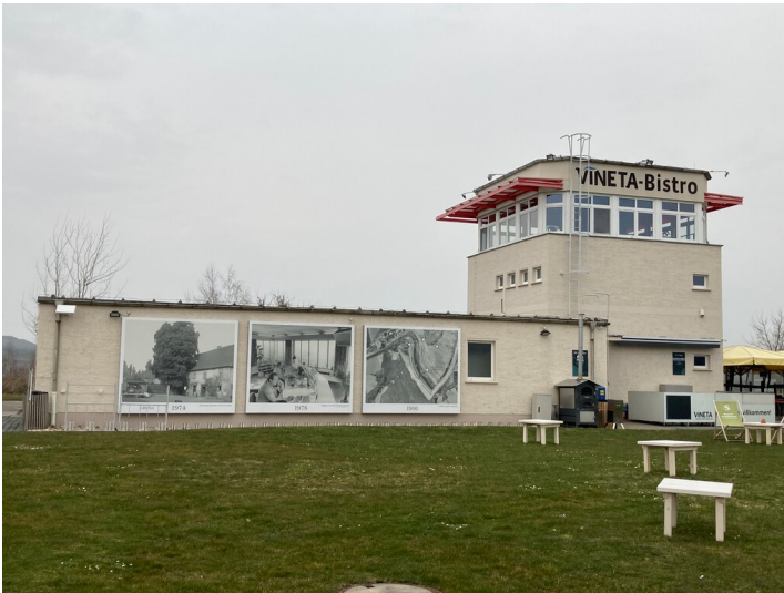
Dispatcherturm; Blick nach Nord Fotograf/Urheber: Josephine Drefßler
