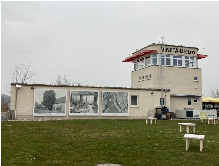
Dispatcherturm; Blick nach Nord Fotograf/Urheber: Josephine Drefßler
