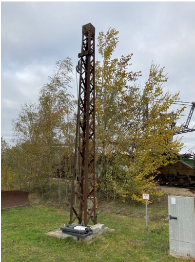
Teil der Objektgruppe Bergbau-Technik-Park (30600134), Freileitungsmast Fotograf/Urheber: Nils Schinker
