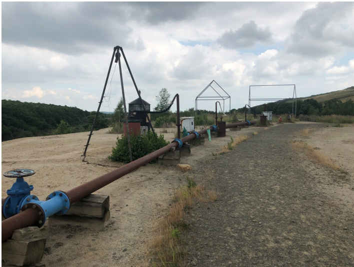
Bergbau-Technik-Park, Filterbrunnen Fotograf/Urheber: Cynthia Thomas
