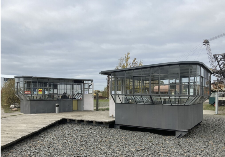
Bergbau-Technik-Park, beide Leitstände der Abraumförderbrücke Böhlen 2 Fotograf/Urheber: Vincent Haburaj
