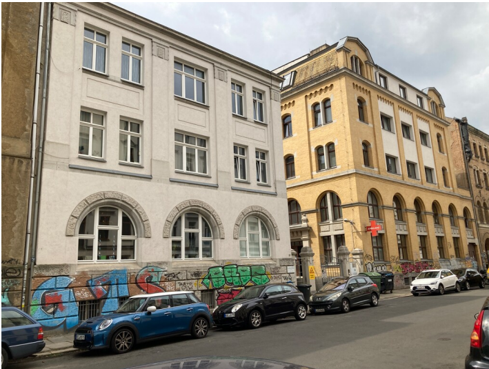
nördliche Giebelseite des Umspannwerkes und benachbarten Beamtenwohnhauses aus nordöstlicher Richtung Fotograf/Urheber: Isabell Schmock-Wieczorek
