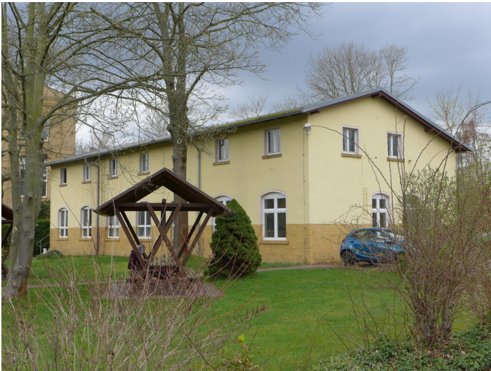
ehemalige Zählerwerkstatt aus nordöstlicher Richtung Fotograf/Urheber: Corinna Wobbe
