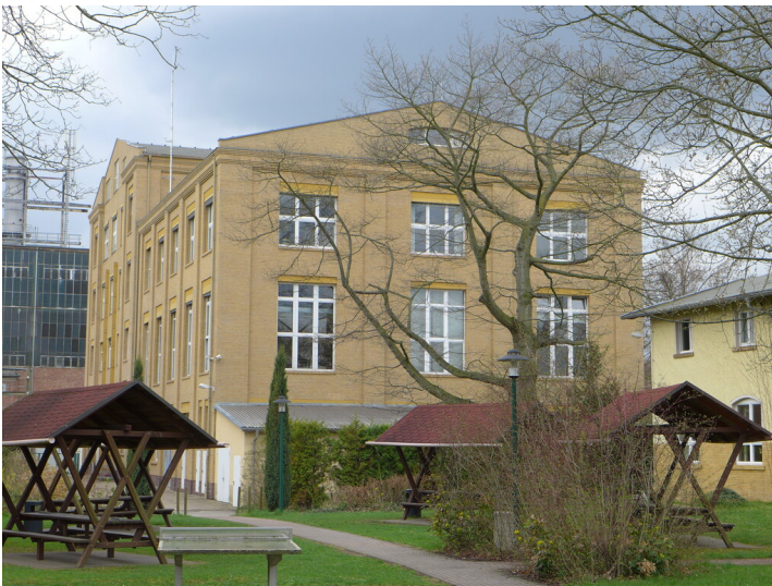
Ehemalige Kohlenmahl- und Trocknungsanlage mit Blick auf die nördliche Giebelseite Fotograf/Urheber: Corinna Wobbe
