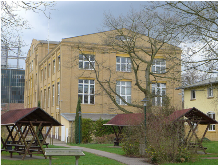
Ehemalige Kohlenmahl- und Trocknungsanlage mit Blick auf die nördliche Giebelseite Fotograf/Urheber: Corinna Wobbe
