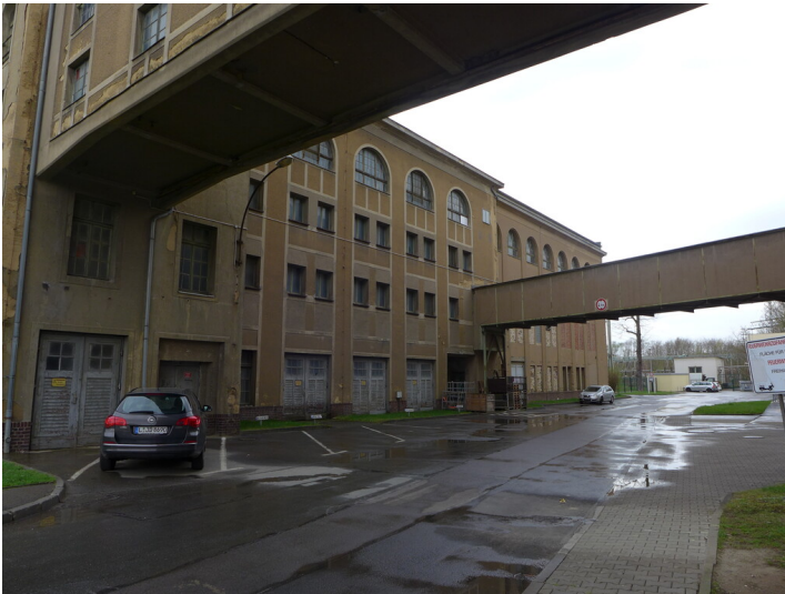
westliche Traufseite des Schalt- und Umspannhauses mit Blick Richtung Süden Fotograf/Urheber: Corinna Wobbe
