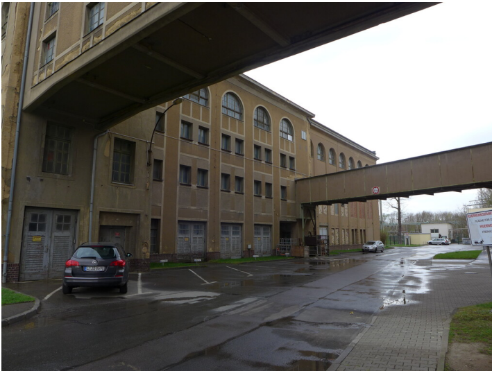
westliche Traufseite des Schalt- und Umspannhauses mit Blick Richtung Süden Fotograf/Urheber: Corinna Wobbe
