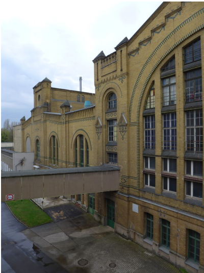
Blick auf die östliche Giebelseite von Maschinen- und Kesselhaus Richtung Westen Fotograf/Urheber: Corinna Wobbe
