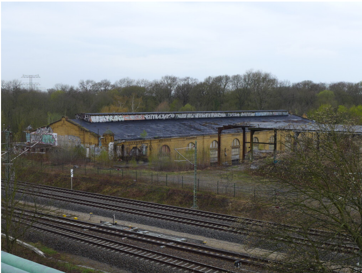
Kohlenschuppen aus östlicher Richtung Fotograf/Urheber: Corinna Wobbe
