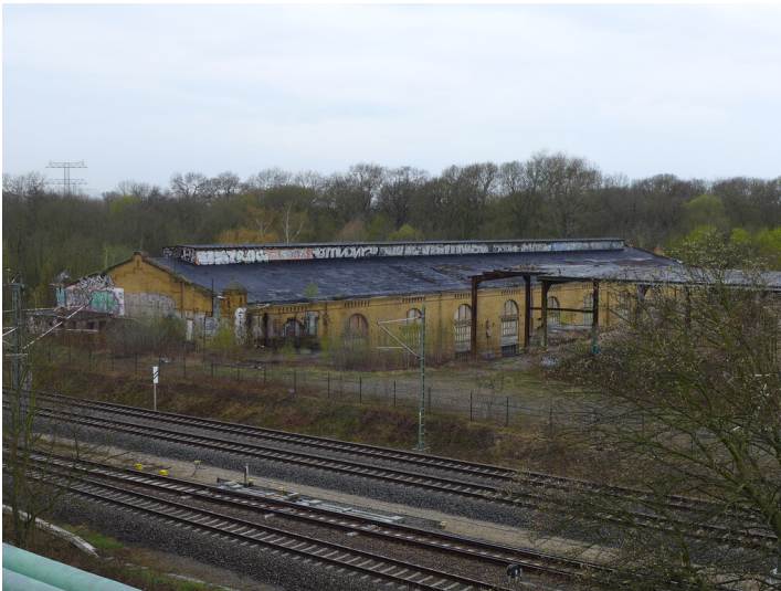
Kohlenschuppen aus östlicher Richtung Fotograf/Urheber: Corinna Wobbe
