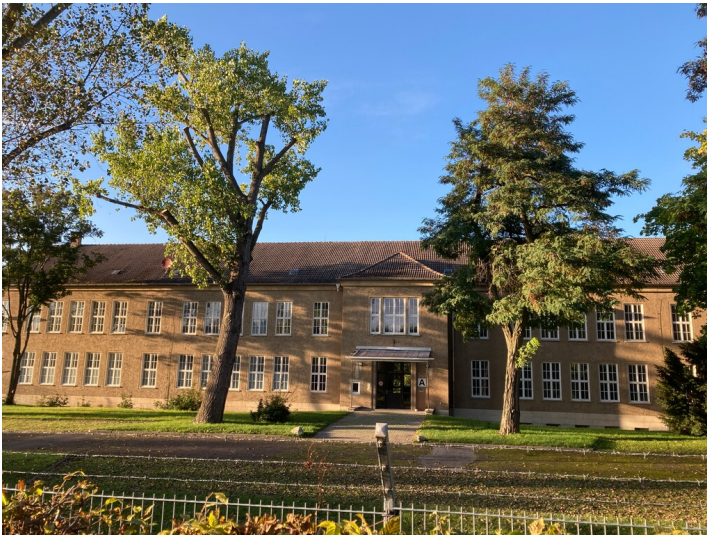
westlicher Gebäudefüßel, mit Blick Richtung Norden Fotograf/Urheber: Nils Schinker
