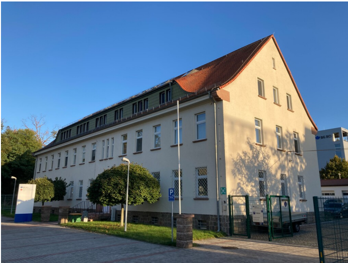
Blick auf die nordwestliche Gebäudeecke Fotograf/Urheber: Nils Schinker
