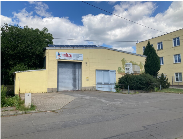
südliche Giebelseite des Mehrzweckgebäudes Fotograf/Urheber: Isabell Schmock-Wieczorek
