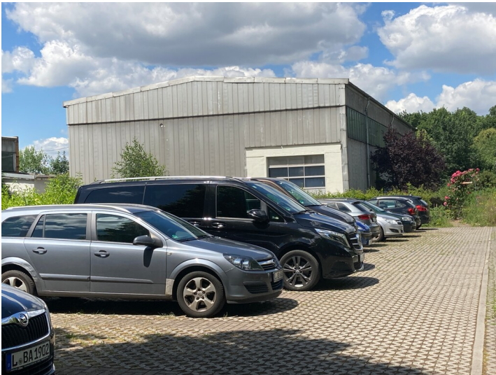
südliche Giebelseite der Mehrzweckhalle Fotograf/Urheber: Isabell Schmock-Wieczorek
