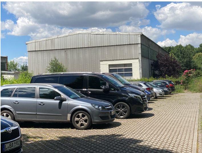
südliche Giebelseite der Mehrzweckhalle Fotograf/Urheber: Isabell Schmock-Wieczorek
