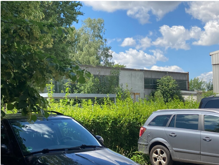
Blick auf die westliche Traufseite der Mehrzweckhalle Fotograf/Urheber: Isabell Schmock-Wieczorek
