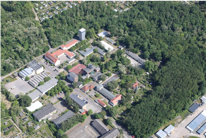
Institutsneubauten im linken Bildbereich, Luftbildaufnahme aus nordwestlicher Richtung Fotograf/Urheber: Ronald Heynowski
