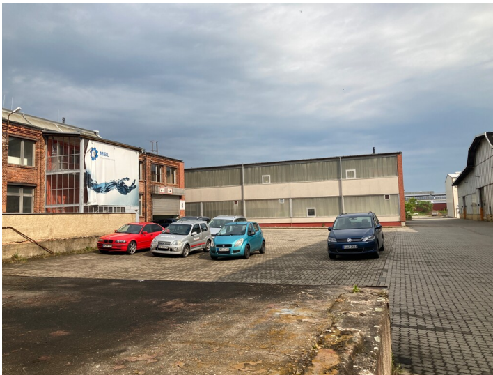
Hallengebäude im rückwärtigen Bereich des Fabrikareals, Blick Richtung Norden Fotograf/Urheber: Isabell Schmock-Wieczorek
