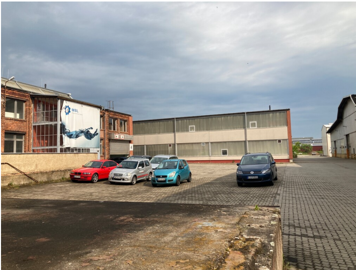
Hallengebäude im rückwärtigen Bereich des Fabrikareals, Blick Richtung Norden Fotograf/Urheber: Isabell Schmock-Wieczorek
