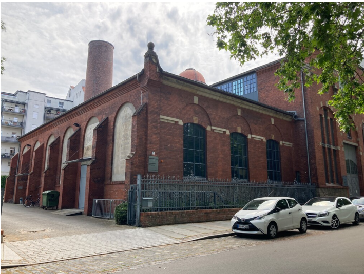
ehemaliges Kraftwerk aus nordwestlicher Richtung, im Vordergrund das Maschinenhaus Fotograf/Urheber: Isabell Schmock-Wieczorek
