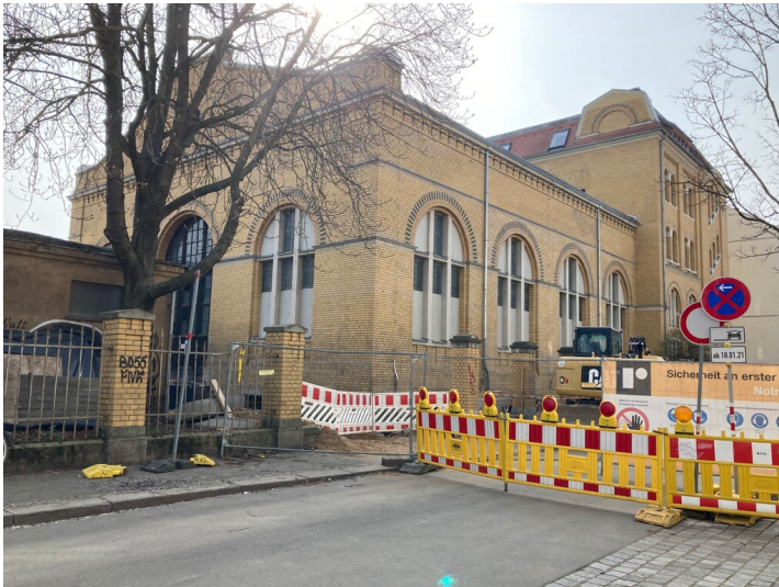
Kesselhaus aus nördöstlicher Richtung Fotograf/Urheber: Josephine Drefßler
