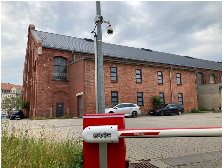
östlicher Teil der Traufseite, aus nördlicher Richtung Fotograf/Urheber: Isabell Schmock-Wieczorek
