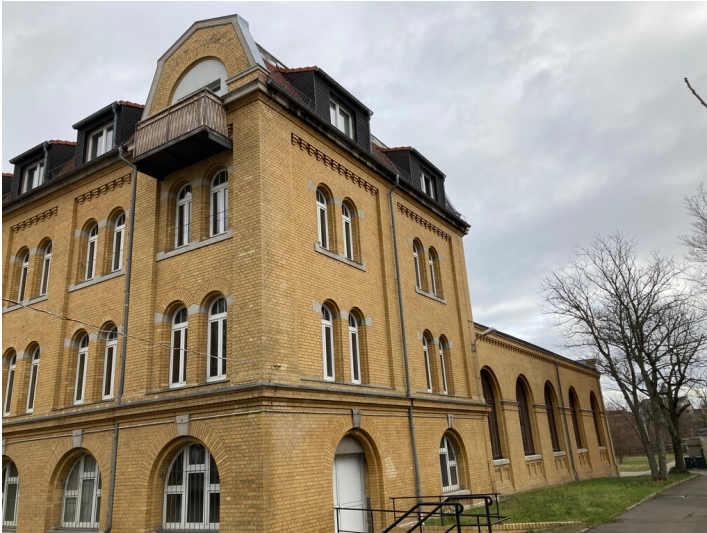
Maschinenhaus aus westlicher Richtung Fotograf/Urheber: Isabell Schmock-Wieczorek
