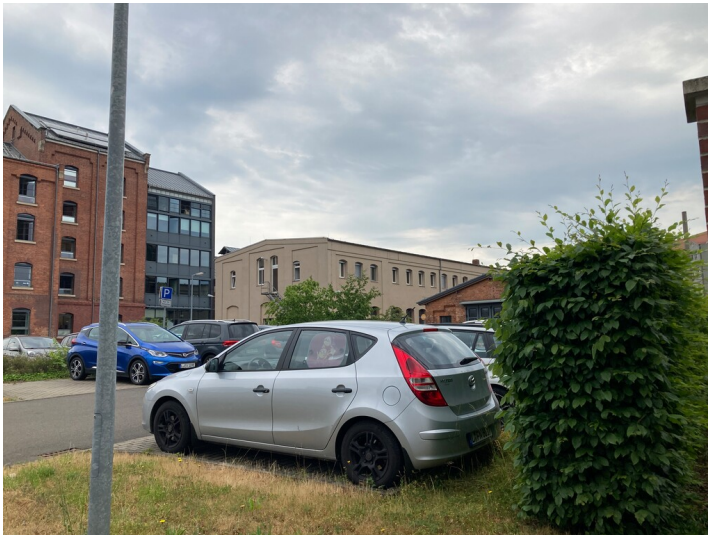
Werkstattgebäude aus südwestlicher Richtung Fotograf/Urheber: Isabell Schmock-Wieczorek
