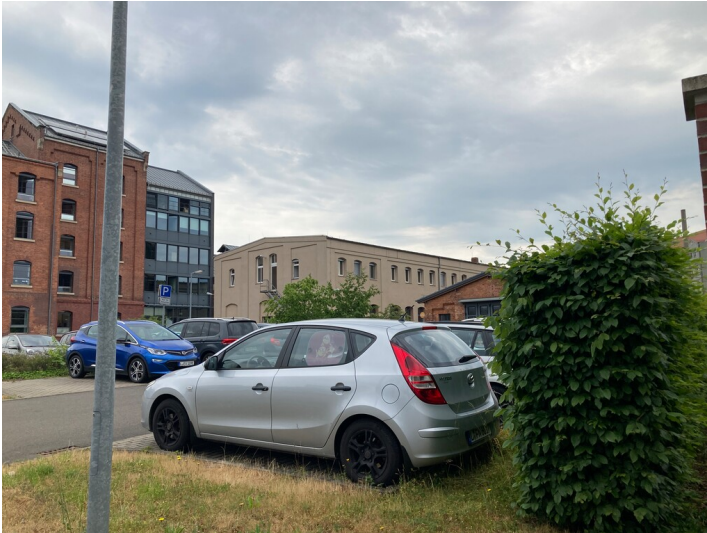
Werkstattgebäude aus südwestlicher Richtung Fotograf/Urheber: Isabell Schmock-Wieczorek
