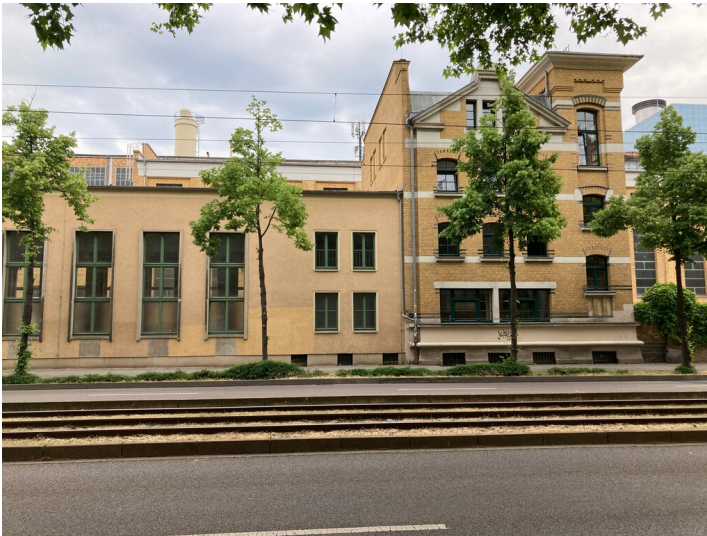
ehemaliges Accumulatorenhaus mit Anbau auf Nordseite, aus westlicher Richtung Fotograf/Urheber: Isabell Schmock-Wieczorek
