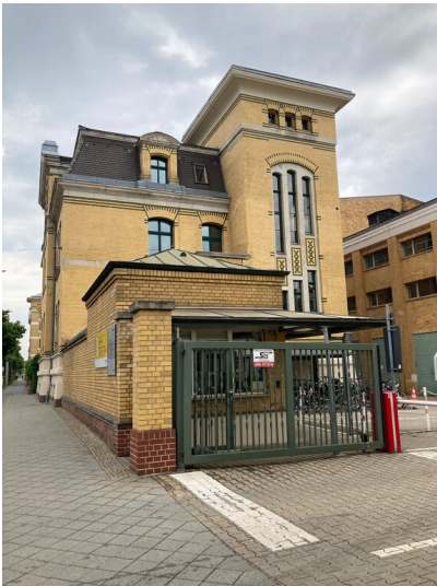
südliche Gebäudeseite mit dem Treppenturm Fotograf/Urheber: Isabell Schmock-Wieczorek
