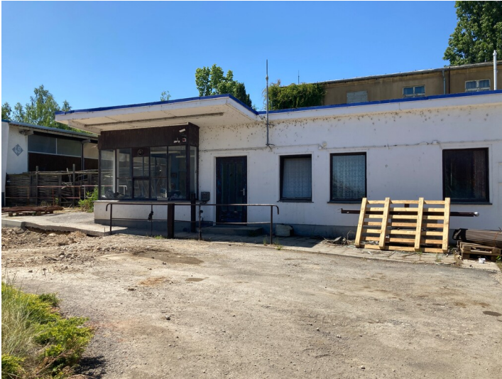
Pförtnerhaus aus östlicher Richtung Fotograf/Urheber: Josephine Drefßler
