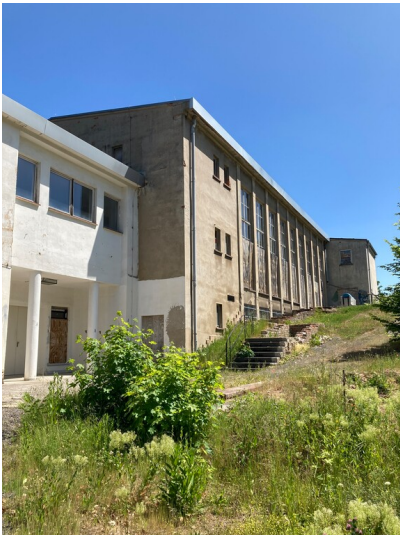
westliche Gebäudeseite der Lehrwerkstatt mit Speisesaal am südlichen Ende, Blick Richtung Südosten Fotograf/Urheber: Isabell Schmock-Wieczorek
