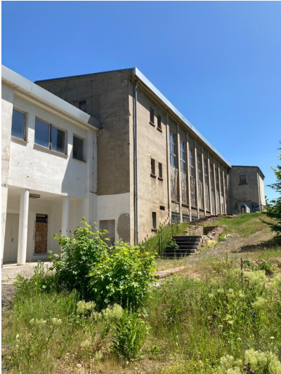
westliche Gebäudeseite der Lehrwerkstatt mit Speisesaal am südlichen Ende, Blick Richtung Südosten Fotograf/Urheber: Isabell Schmock-Wieczorek
