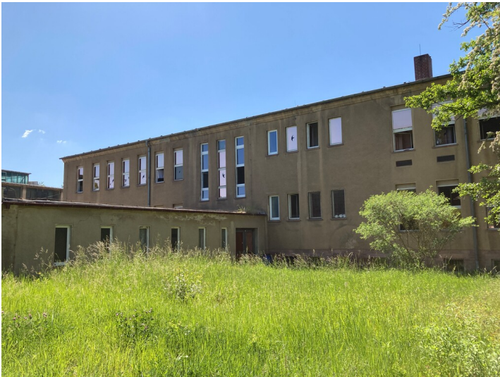
Gebäuderückseite mit Anbau aus nordwestlicher Richtung Fotograf/Urheber: Isabell Schmock-Wieczorek
