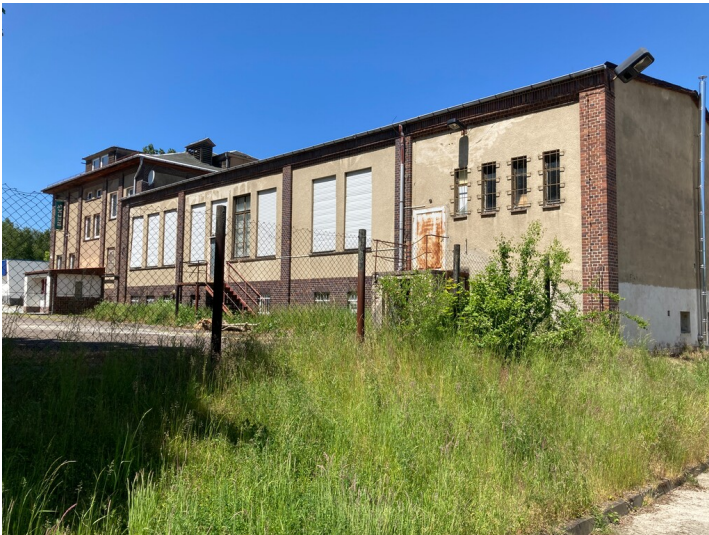
südliche Traufseite aus südöstlicher Richtung Fotograf/Urheber: Josephine Dreßler
