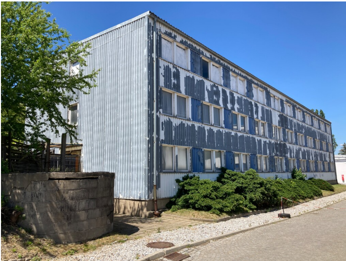
östliche Traufseite aus südöstlicher Richtung Fotograf/Urheber: Josephine Drefßler
