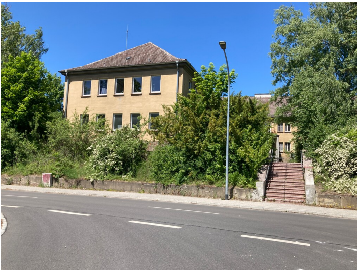
Südseite des westlichen Gebäudeflügels Fotograf/Urheber: Josephine Drefßler
