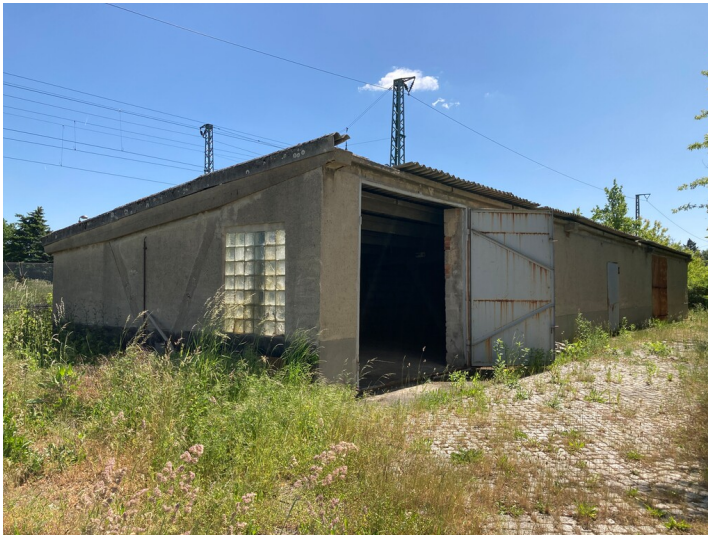
Blick auf die nordwestliche Gebäudeecke Fotograf/Urheber: Isabell Schmock-Wieczorek
