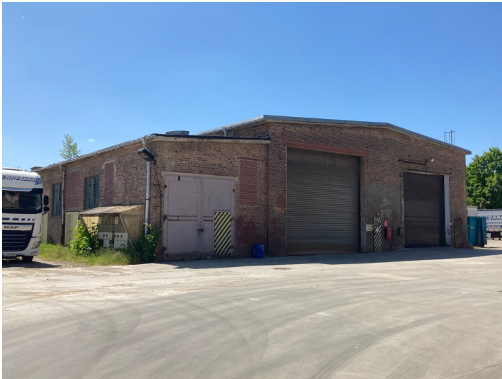
nördliche Giebelseite aus nordöstlicher Richtung Fotograf/Urheber: Josephine Drefßler
