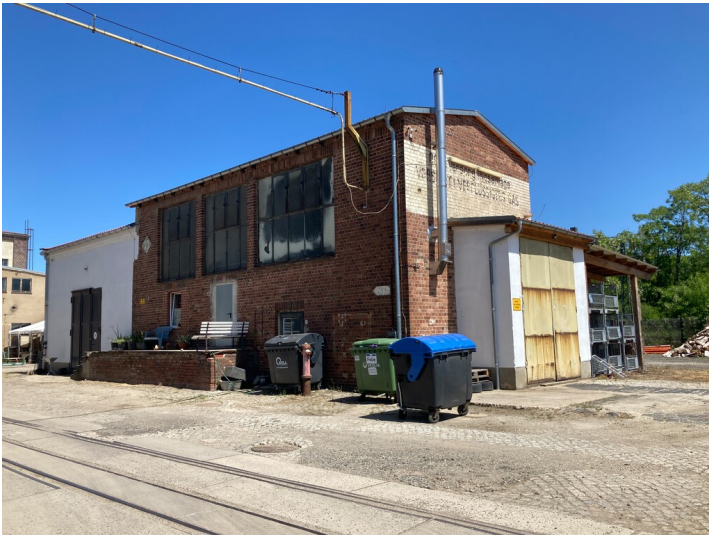
Blick auf die westliche Traufseite von Südwest Fotograf/Urheber: Josephine Drefßler
