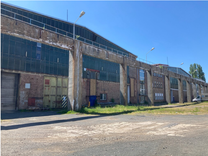
nördliche Giebelseite der beiden Fabrikhalle mit der davor platzierten Freikrananlage, Blick Richtung Südwest Fotograf/Urheber: Josephine Drefßler
