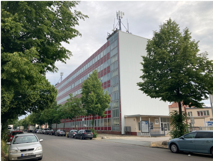
Bürogebäude und Sozialbau aus südwestlicher Richtung, straßenseitig Fotograf/Urheber: Isabell Schmock-Wieczorek
