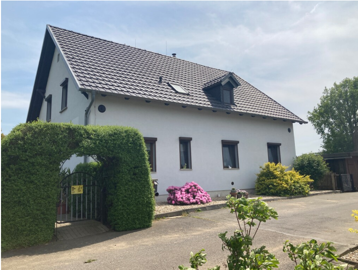
Beamtenwohnhaus und Kontorgebäude aus westlicher Richtung Fotograf/Urheber: Isabell Schmock-Wieczorek
