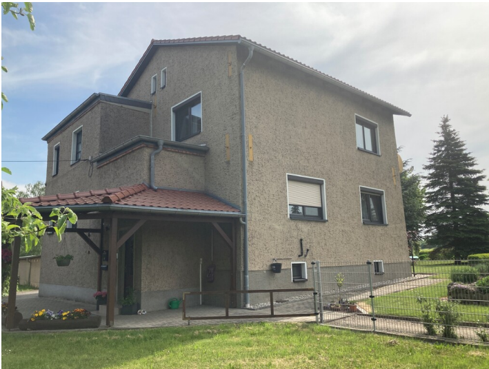
Maschinenhaus aus westlicher Richtung Fotograf/Urheber: Isabell Schmock-Wieczorek
