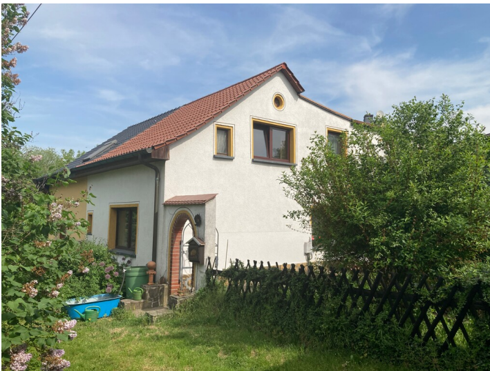
Kontorgebäude am alten Werksstandort, südöstliche Giebelseite Fotograf/Urheber: Isabell Schmock-Wieczorek
