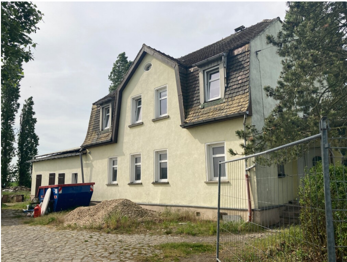
Wohnhaus Braunkohlenwerk Gottes Segen jüngerer Standort bei Seelingstädt, nordöstliche Traufseite Fotograf/Urheber: Isabell Schmock-Wieczorek
