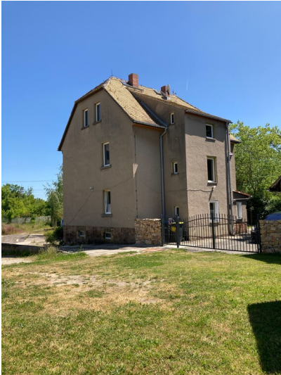
Blick aus nordwestlicher Richtung Fotograf/Urheber: Isabell Schmock-Wieczorek
