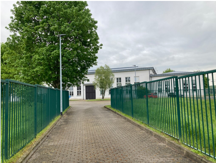
Pumpwerk aus westlicher Richtung Fotograf/Urheber: Isabell Schmock-Wieczorek
