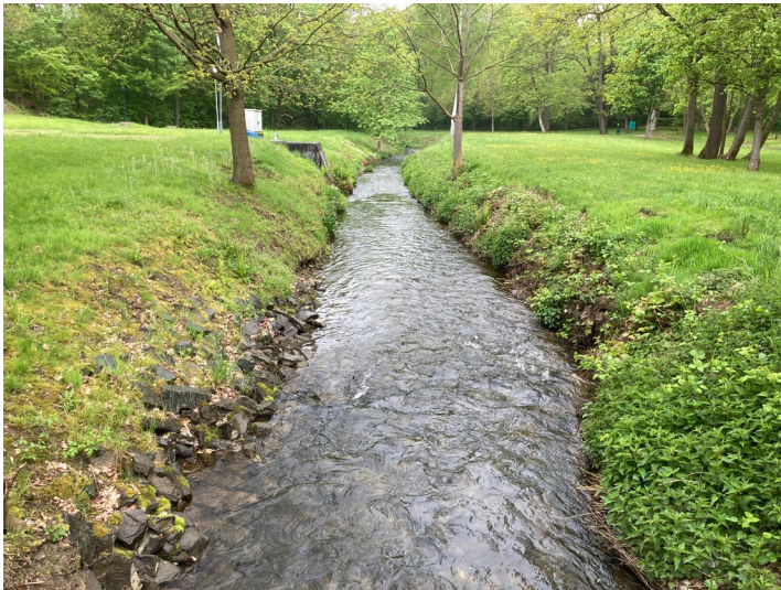
Überleiter über den Steingrundbach im nördlichen Bereich des Bad Lausicker Kurparks Fotograf/Urheber: Josephine Dressler
