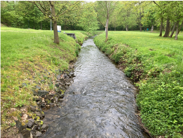
Überleiter über den Steingrundbach im nördlichen Bereich des Bad Lausicker Kurparks Fotograf/Urheber: Josephine Dressler
