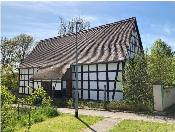
Scheune mit Blick Richtung Westen Fotograf/Urheber: Isabell Schmock-Wieczorek
