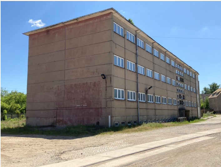
Blick aus nordwestlicher Richtung Fotograf/Urheber: Josephine Drefßler
