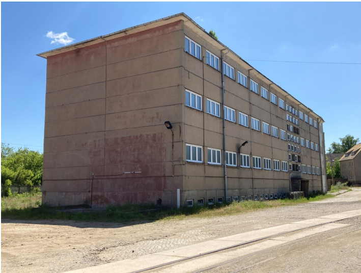
Blick aus nordwestlicher Richtung Fotograf/Urheber: Josephine Drefßler
