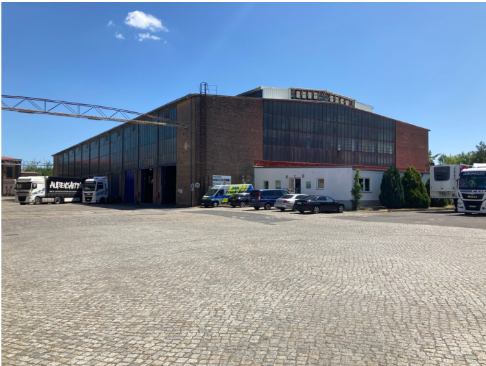
Blick auf nordwestliche Gebäudeecke Fotograf/Urheber: Josephine Dreßler
