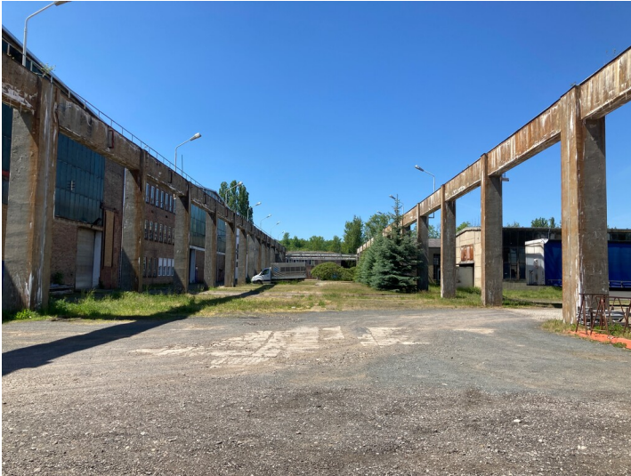
Blick entlang der Freikrananlage Richtung Westen Fotograf/Urheber: Josephine Drefßler
